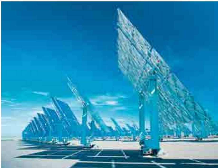
Technologie von ABB sorgt dafür, dass bei großen Solarparks die beweglichen Solar-Module dem Stand der Sonne folgen.
