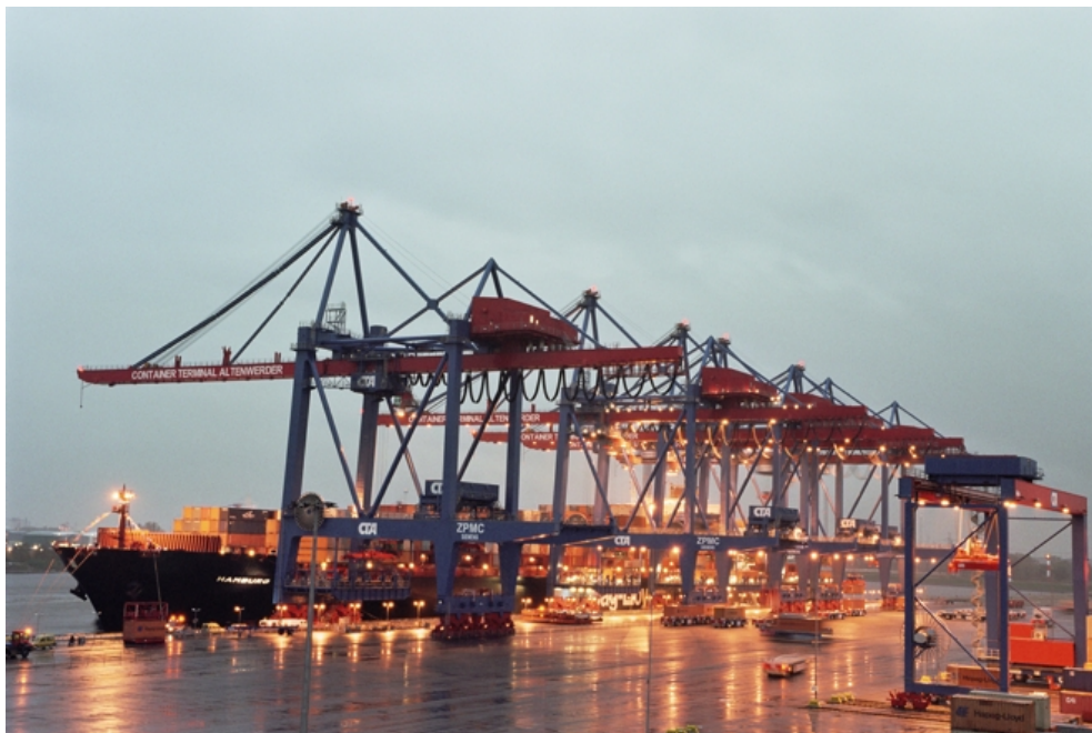
Bild 2: Blick auf das Container-Terminal der HHLA
