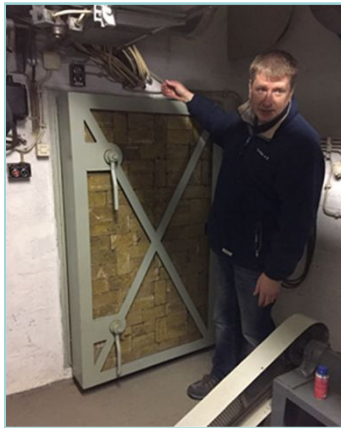
Vor der Strahlenschutzür (Bleieinlagerungen in den Steinen)
