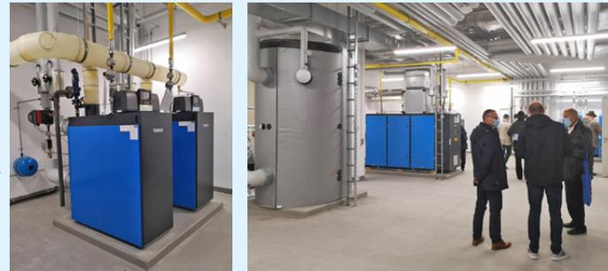
Im "Heizungskeller" überrascht ein gasbetriebenes Blockheizkraftwerk mit 146 kW thermischer und 50 kW elektrischer Leistung. Dieses wird im Bedarfsfall ergänzt von zwei Gas-Brennwertkesseln mit je 250 kW Leistung. Beheizt werden über 12.000 m<sup>2</sup> Nutzfläche mittels einer Fußbodenheizung mit einer Gesamtröhrlänge von über 67 km.
