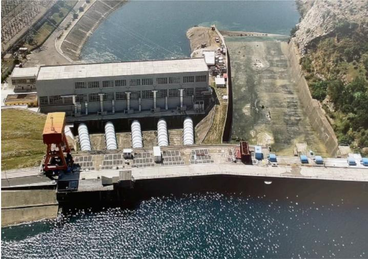
Alleine im **Vau i Dejës Kraftwerk** erzeugen 5 chinesische Francisturbinen zusammen 250 MW und weitere 5 MW die PV-Anlagen auf den Staumauerflächen.
