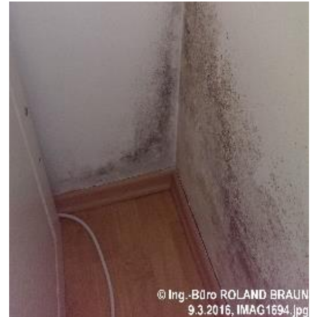
Sichtbarer Schimmelpilzbefall
