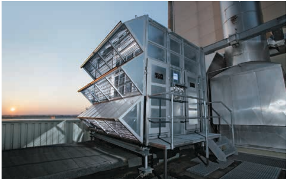
Auf Träger gestellt, kann das Filterhaus von Freudenberg Filtration Technologies nach Bedarf versetzt werden.
