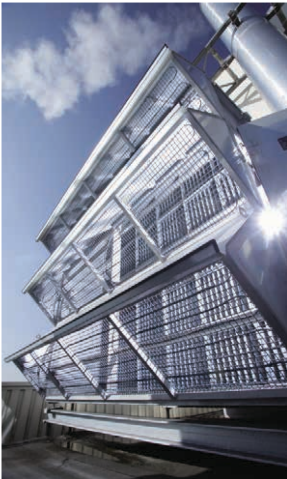
Das Filterhaus von Freudenberg verfügt über ein integriertes Anti-Icing-System.
