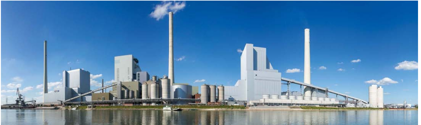
Kraftwerksblöcke 8, 7 und 9 von der Rheinseite aus gesehen.
