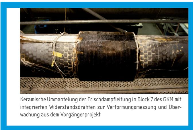
gegenüber dem nicht ummantelten Zustand gesteigert werden. Die technische Machbarkeit der Umwicklung eines geraden Rohres unter Kraftwerksbedingungen wurde in einem Feldversuch im Block 7 des GKM an einer Frischdampfleitung nachgewiesen. Ebenso wurden Herstellungstechniken sowie Überwachungstechniken erprobt. Darüber hinaus entstanden im Rahmen dieses Projekts mehrere Patente.
