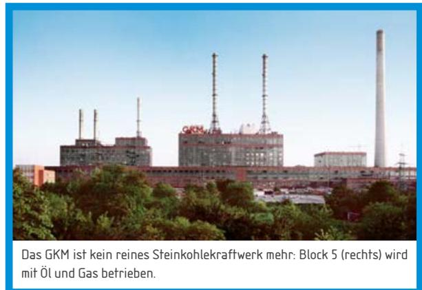
Das GKM ist kein reines Steinkohlekraftwerk mehr: Block 5 (rechts) wird mit Öl und Gas betrieben.
