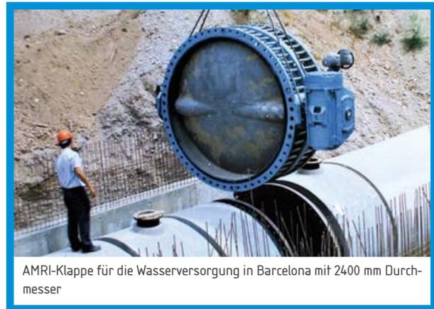
AMRI-Klappe für die Wasserversorgung in Barcelona mit 2400 mm Durchmesser
