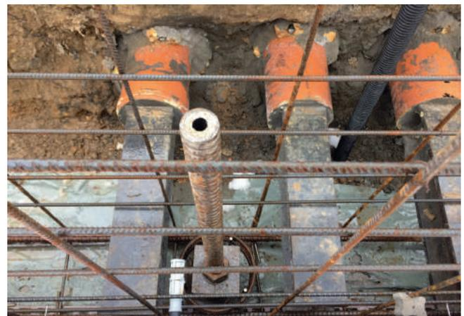
**Verschneidung der Längs- und Querabfangung und Einbindung in die STB-Wange**
