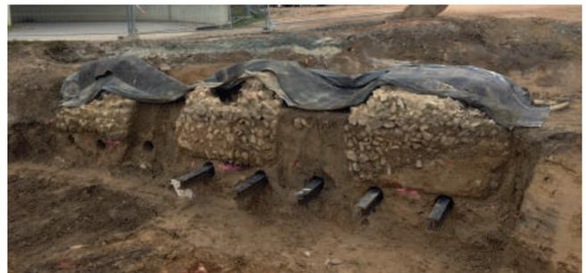
**Versetzte Stahlträger unter freigelegte Fundamente**
