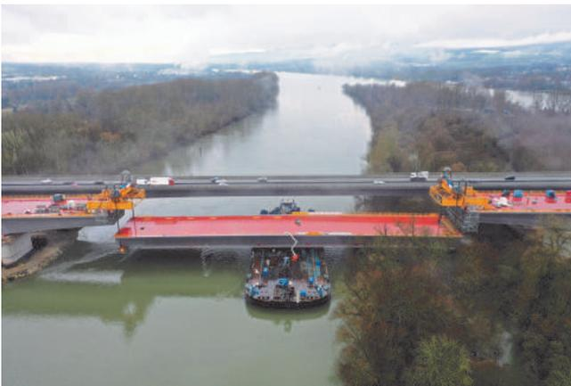
**Schlussstück der Stahlkonstruktion**
