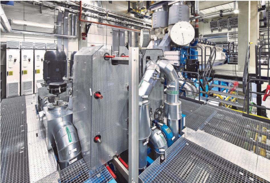
KWK-Modul in der Motorzelle hinter dem Motor mit Wärmetauschern und Pumpen
