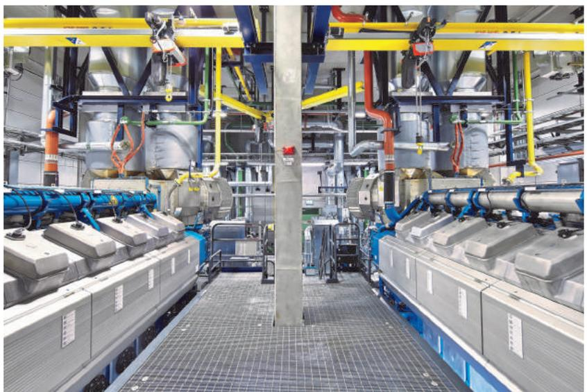
Blick zwischen die beiden Motoren in einer Motorzelle mit der Servicebühne
