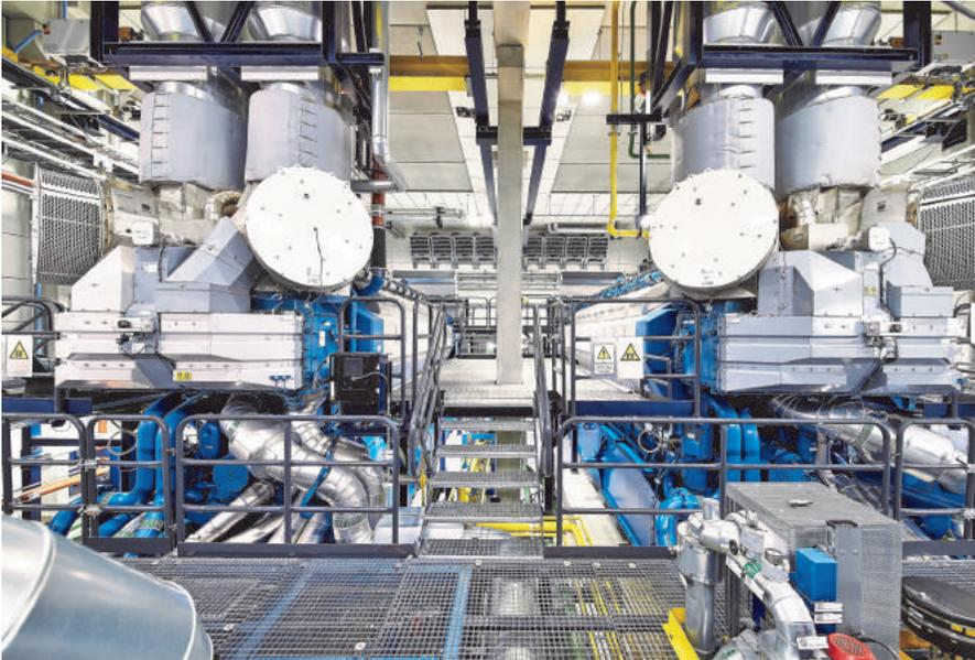
Blick von hinten in die Motorzelle auf die Motoren mit den jeweils 2 Turboladern
