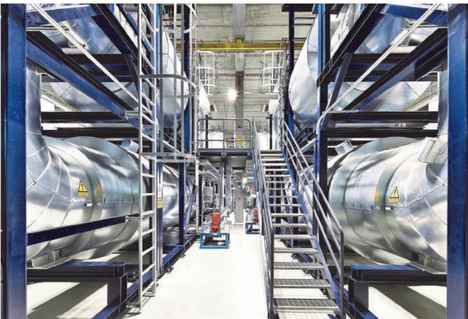
Blick zwischen die Abgasstränge von 2 Motoren mit Schalldämpfern, Katalysatoren und im Hintergrund auf der oberen Ebene die Abgaswärmetauscher
