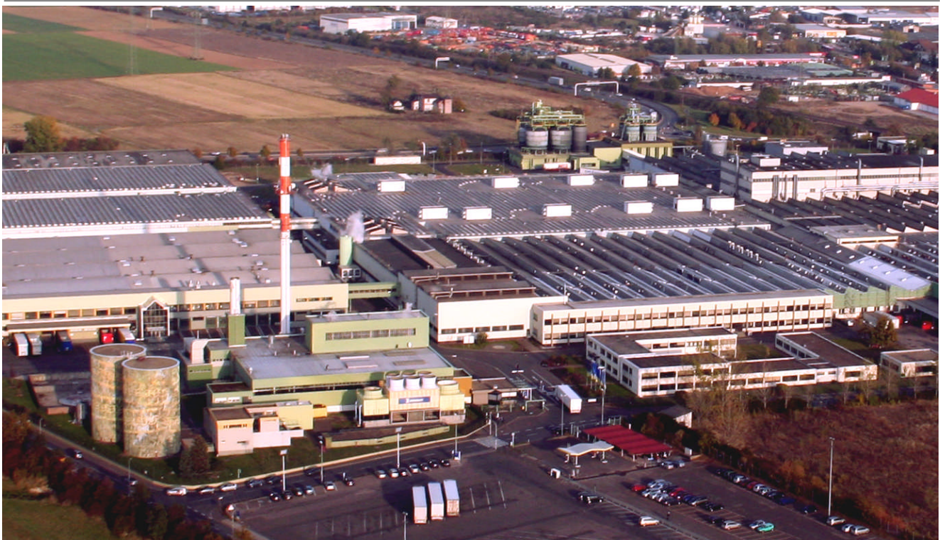
Bild 9- Michelin Werk Bad Kreuznach: Das Werk Bad Kreuznach ist mit mehr als 1.500 Mitarbeitern das größte Werk von Michelin in Deutschland. Jährlich werden hier etwa 8 Millionen PKW-Reifen und 130.000 Tonnen Mischung hergestellt. Es wurde 1965/66 erbaut und seitdem ständig erweitert.
