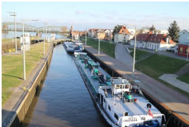
**Beachtliche Ausmaße:** Die Schleuse hat zwei Kammern, jeweils mit einer nutzbaren Länge von ca. 340 Metern und einer Breite von 15 bzw. 20 Metern. Hier ist die 20 Meter breite Kammer abgebildet. Zur Schleusung werden maximal 19.000 Kubikmeter Wasser benötigt. Bilder: M. Schneider
