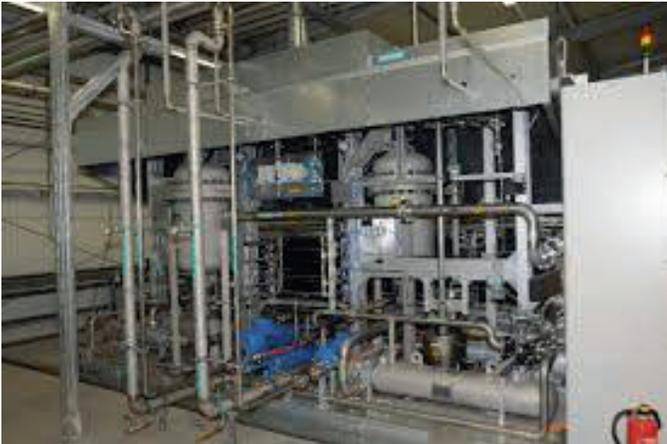
**PEM-Elektrolyseure für schnelle Lastwechsel und bis zu 35 bar Druck**
