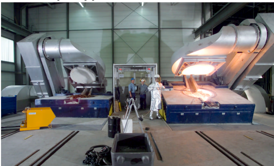
Moderne Gießerei: Tandem-Induktionsschmelzanlage mit 9 MW Leistung.
