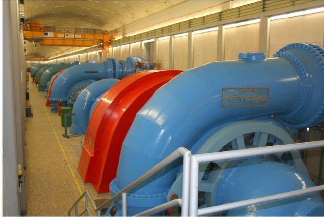
**Imposant:** Blick in die 330 Meter lange Maschinenhalle. Vorn: Turbine mit 100 MW, dahinter Generator/Motor, Pumpe, Maschinendrehzahl 428 U/min
