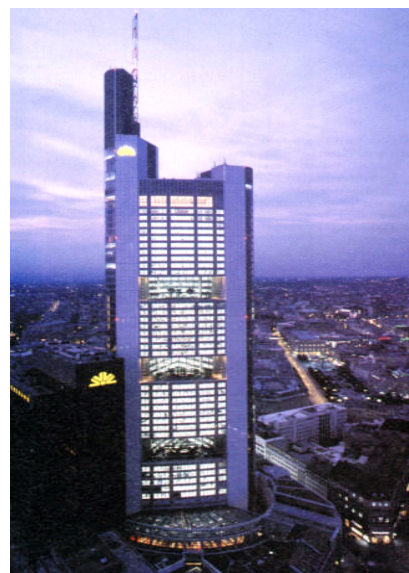
Heute: Das von Imtech ausgerüstete Commerzbank-Hochhaus in Frankfurt
