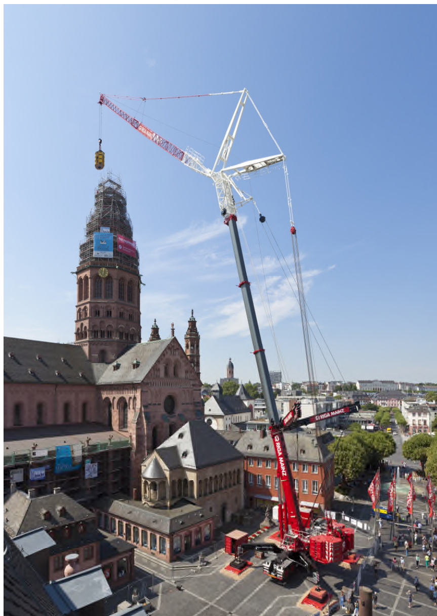
Bild 1 Ein historisches Ereignis für Mainz: Ein Teleskopkran mit voll ausgeschobenem Teleskopausleger und wippbarer Gitterspitze bewältigte die erforderlichen Hebearbeiten ohne Probleme. Höhe: ca. 100 m, Ausladung: 64 m, maximales Gewicht: 16 t. Auf der Rückseite des Krans: Das für diese Ausladung erforderliche Ballastgewicht.
