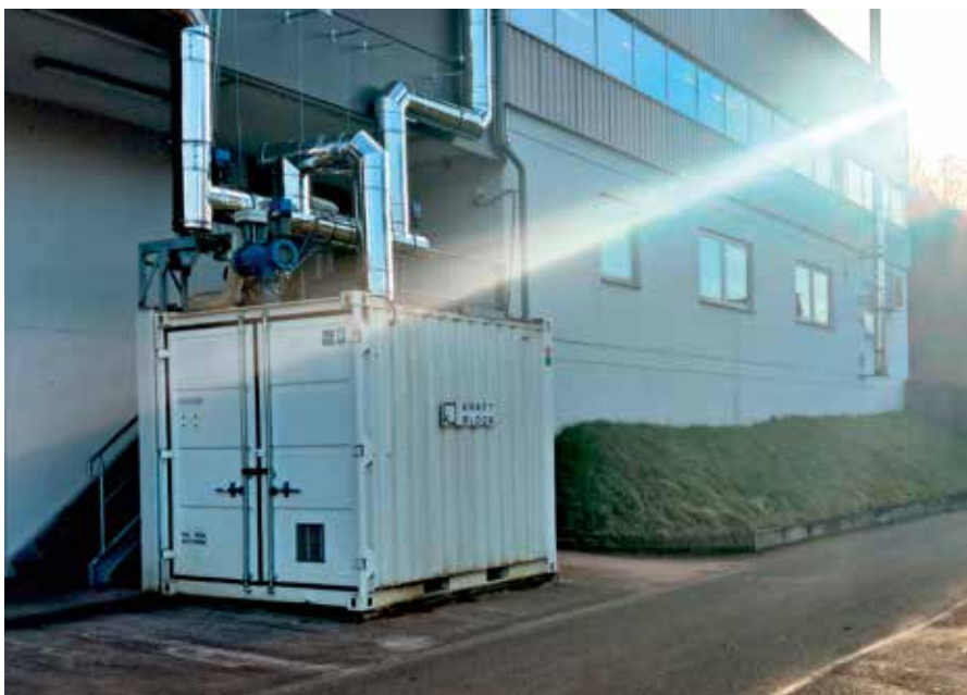
„Kraftblock“: Power-to-Heat-Elemente mit Gebläse blasen Wärme bis 1 000°C in den hauseigenen Speicher.
