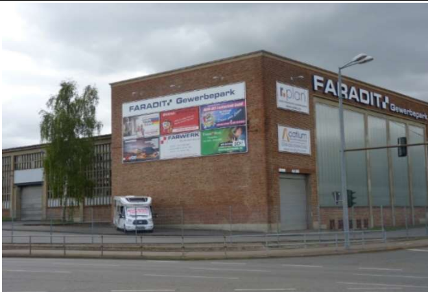
Foto: FARADIT Gewerbehof GmbH
