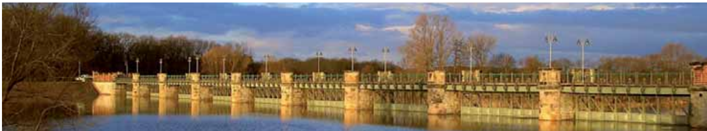
Das Pretziener Wehr, etwa 7 km nordöstlich von Schönebeck (Elbe) zwischen Pretzien und Ranies gelegen, dient seit dem Jahr 1875 zuverlässig der Wasserstandsregulierung der Elbe. Es wurde bisher 56-mal im Winter und 8-mal im Sommer bei Hochwasser geöffnet. Foto: Hans-Dieter Tyrock
