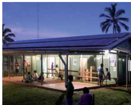
In einem entlegenen Krankenhaus in Papua Neuguinea liefern Tesvolt Speicher und eine PV-Anlage zuverlässig Strom. Foto: Tesvolt Australia
