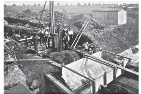
*Baugrubenausbau an der Kreuzung des Klinke-Bachlaufs.*
