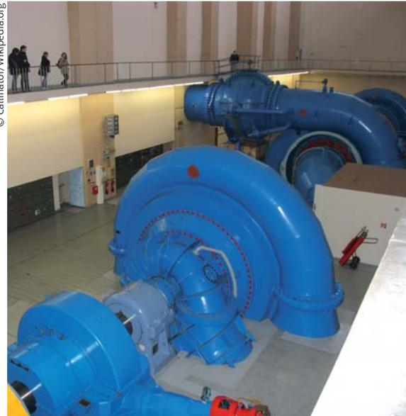
Blick in die Maschinenhalle des Pumpspeicher-Kraftwerks Wendefurth mit zwei 40-Megawatt-Turbinen, das mit dieser Leistung zu den mittelgroßen PSW der Vattenfall Wasserkraft GmbH zählt.
