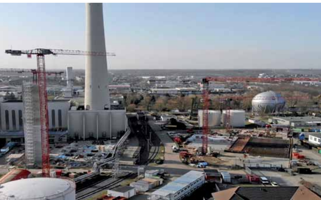
Die Modernisierungsarbeiten auf dem Gelände des HKW Mitte an der Hamburger Straße sind in vollem Gange.
