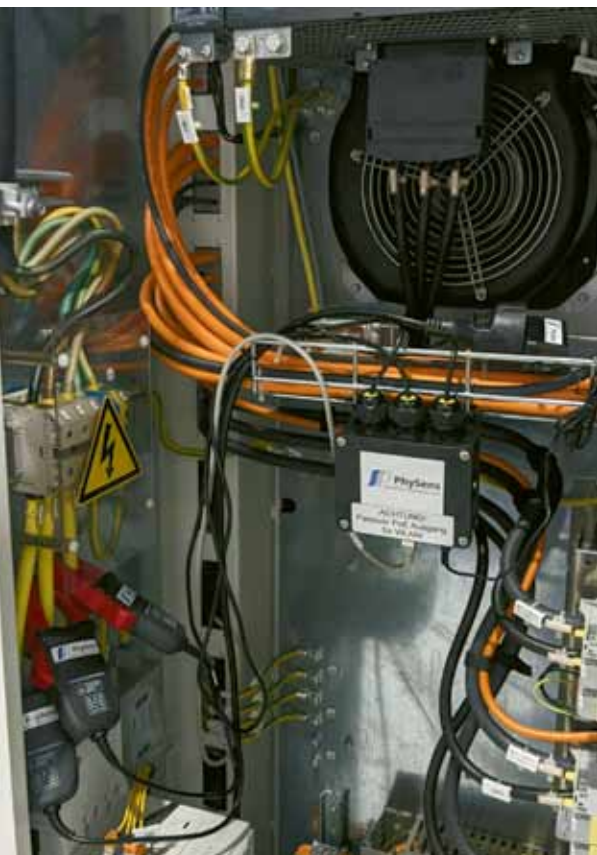
Energie-Monitoring-System von PhySens im Einsatz für ein metallverarbeitendes Unternehmen: Die Technologie unterstützt den Produktionsprozess und überwacht den Stromverbrauch.
