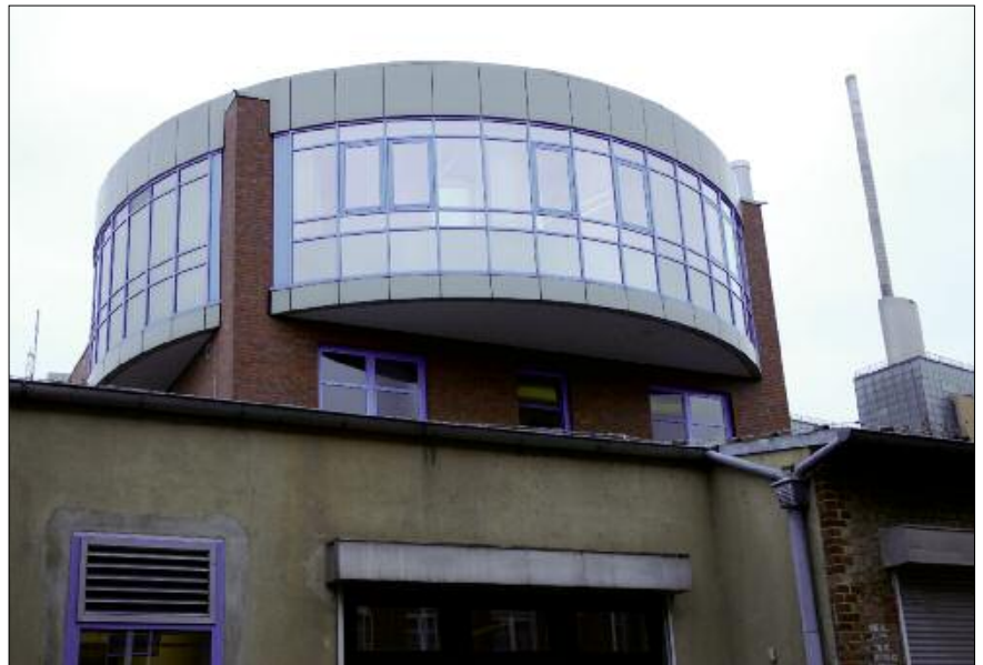
Leitstellengebäude der Verkehrsmanagementzentrale auf dem Betriebsgelände der üstra in Hannover-Linden.
