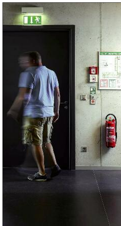
Erste Maßnahme im Brandfall ist der Griff zum nächsten Feuerlöscher.
