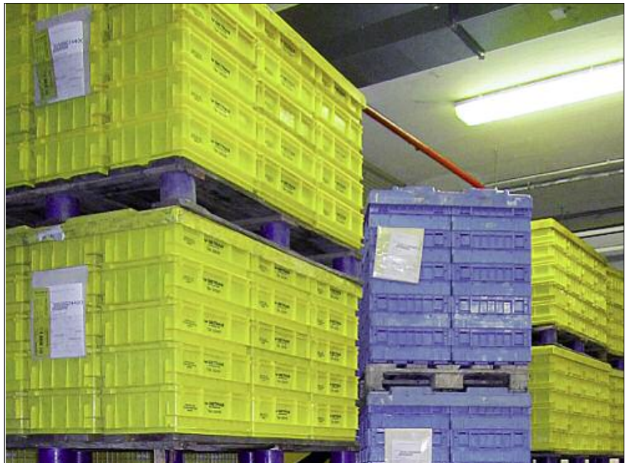
Falsch installierte Notlaufleitung einer Sprinkleranlage.
