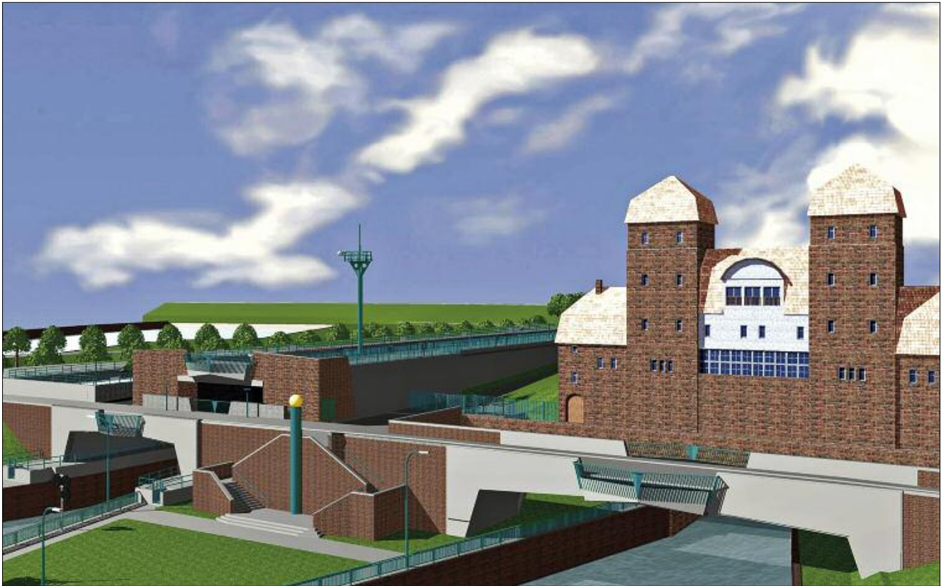
So imposant sieht die Weserschleuse Minden nach ihrer Fertigstellung 2013 aus.
