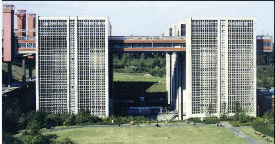
Imposant: Die Ansicht des Schiffshebwerks von Nordosten.
