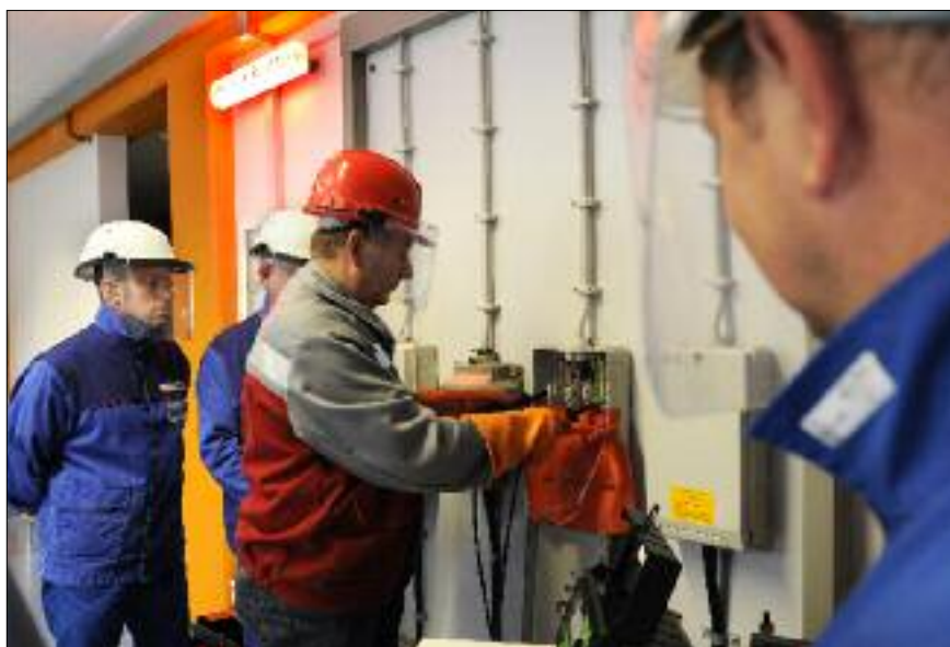
Messungen an unter Spannung stehenden elektrischen Anlagen. Foto: enercity
