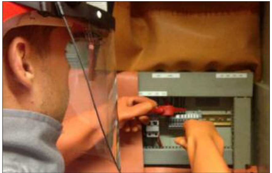
Montagearbeiten bei der Fehlereingrenzung in Hilfsstromkreisen. Fotos (2): enercity
