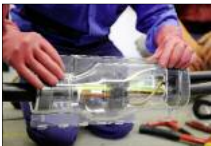
Niederspannungskabelmontage unter Spannung.
