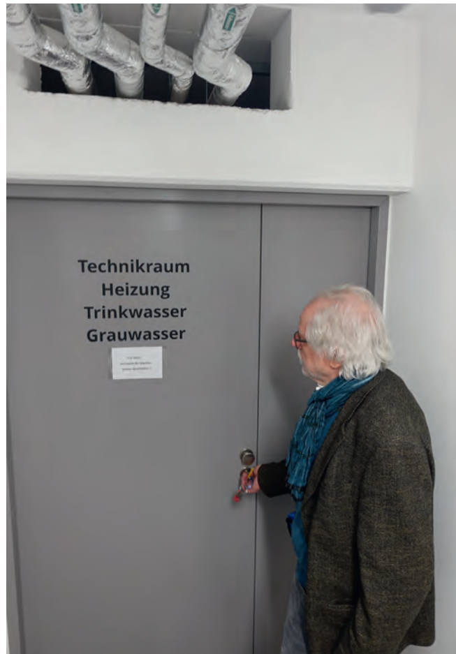
▲ Zugang zum Technikraum im UG der 7-geschossigen Apartmentanlage für Studenten in Berlin-Pankow. Hier wird das gesamte Duschwasser der 442 Bewohner nach Aufbereitung zur WC-Spülung verwendet. Zugleich wird Wärme zurückgewonnen und für die Trinkwassererwärmung eingesetzt. Bild: König
