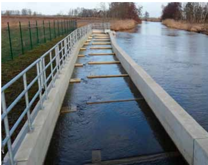
Die Wehranlage mit Fischaufstieg.
