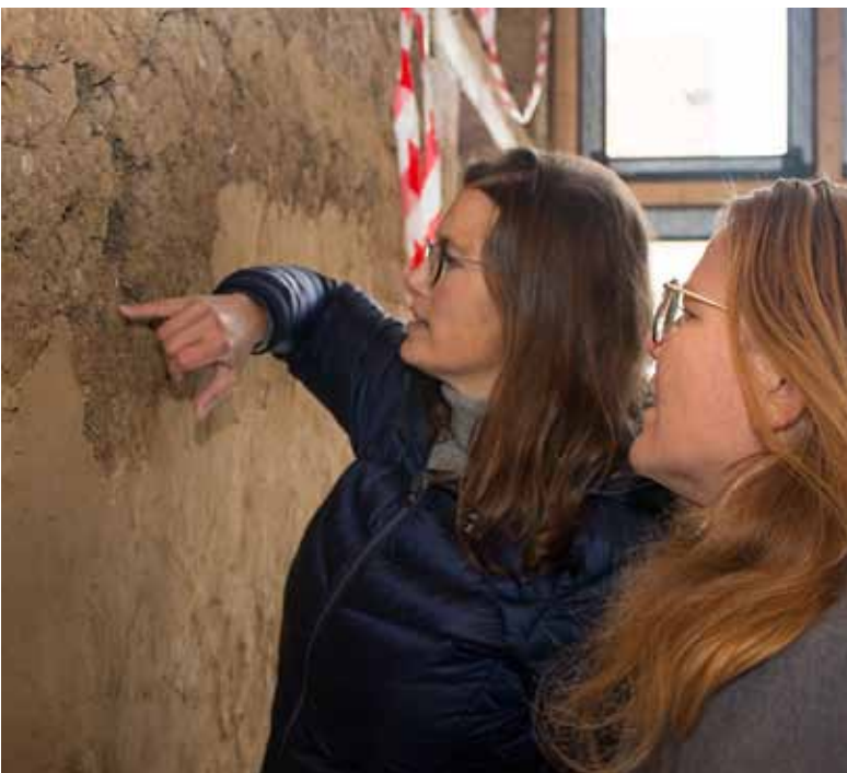
Franziska Knoll interessiert sich dafür, wie Steffi Rückauf aus Pouch (v.l.) ihre Lehmscheune zum Wohnhaus umbaut.
