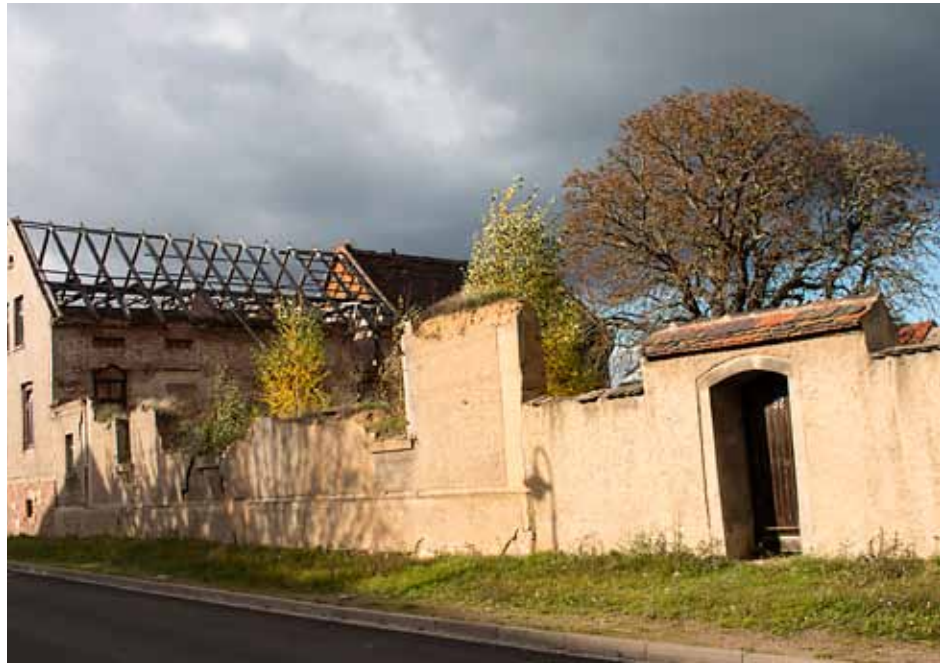
Lehm aus Abrissbauten wie hier in Großzöberitz lässt sich recyceln und als Baumaterial wiederverwenden. Fotos (2): Kathrain Graubaum
