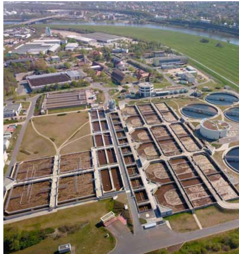
Die Aufnahme zeigt die Kläranlage von Dresden. Foto: Stadtentwässerung Dresden GmbH
