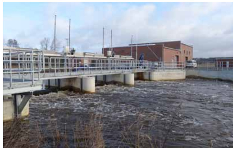
Die Anlage des neuen Pumpwerkes mit dem Oberwehr
