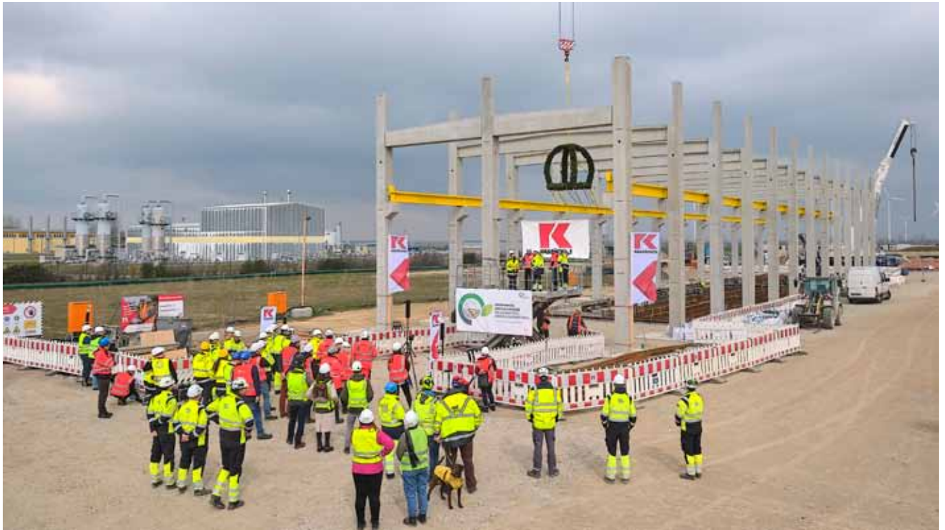
Richtfest für das Elektrolysegebäude im Energiepark Bad Lauchstädt.
