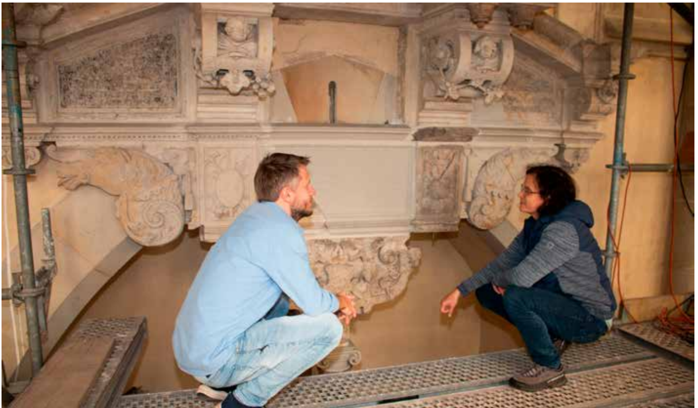
Patrick Saalfeld und Claudia Böttcher schauen sich am Grabdenkmal im südlichen Seitenschiff des Magdeburger Domes an, wie sich die "realen" Puzzleteile zusammenfügen. Ein fehlendes Teil der Schrifttafel wurde mit dem Sand-3D-Drucker hergestellt.
