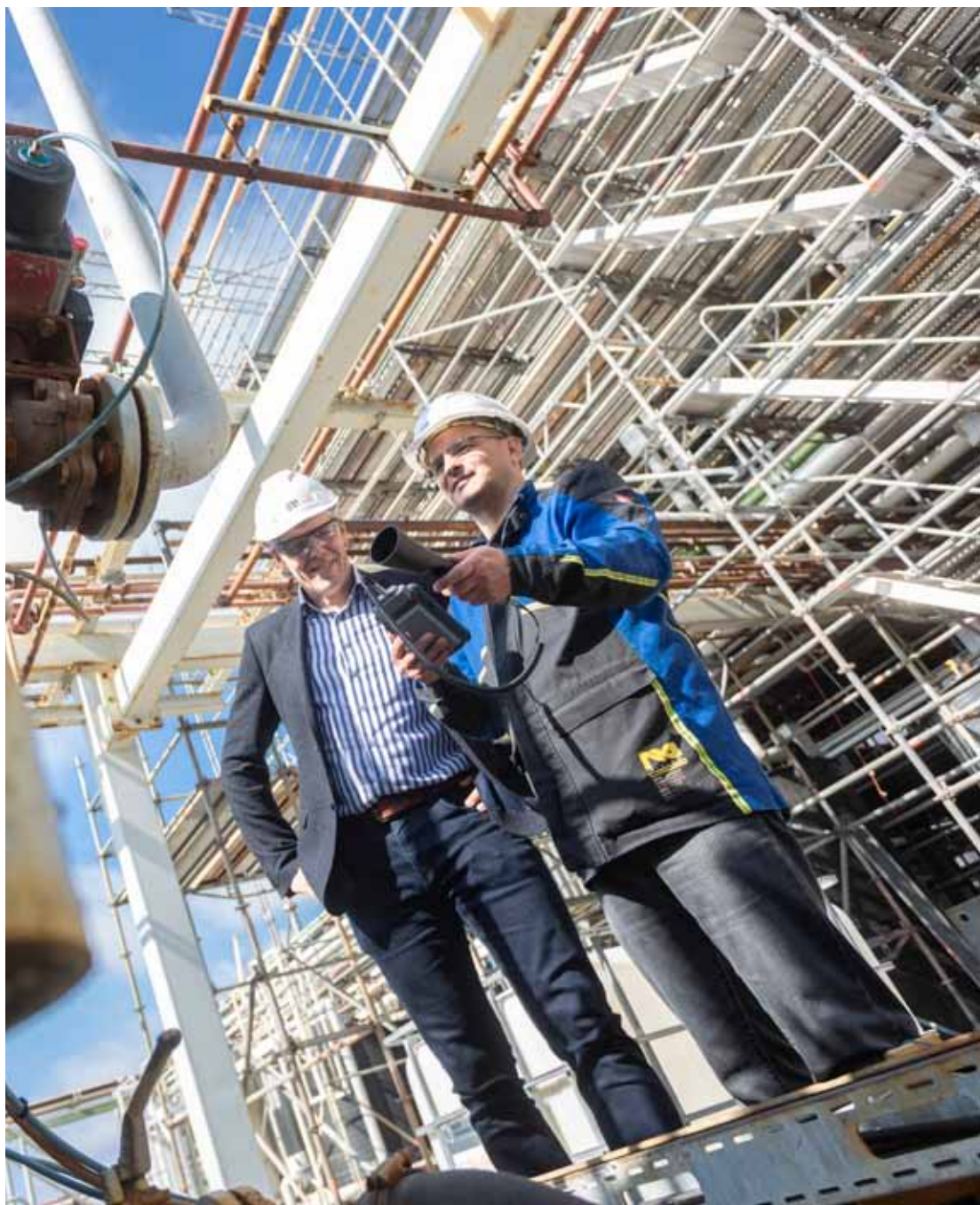
Thomas Micka von der LENA (links) erklärt bei der BNT Chemicals GmbH in Bitterfeld-Wolfen ein Ultraschallprüfgerät zur Bewertung der Druckanlage.
