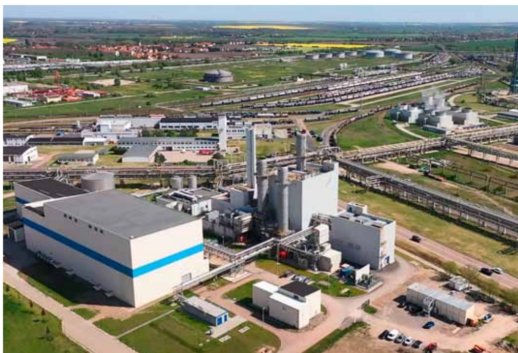
Der Chemiepark Leuna zählt zu den größten in Europa.
