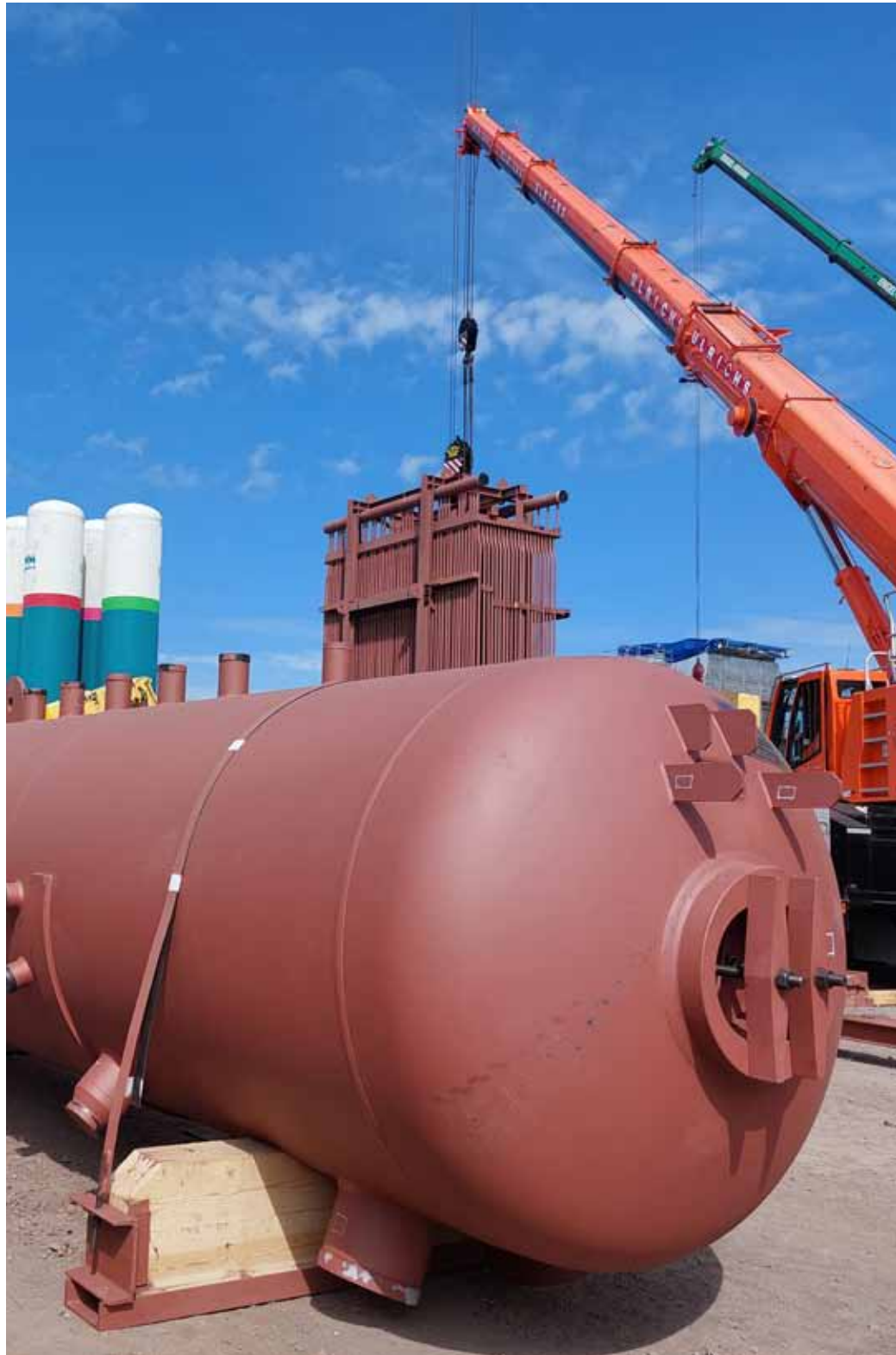
Die Dampftrommel für den neuen Block 3 des Müllheizkraftwerkes Magdeburg-Rothensee MHKW. Die neue und hochmoderne Verbrennungsanlage wird hauptsächlich Industriekunden mit Strom versorgen. Foto: MHKW
