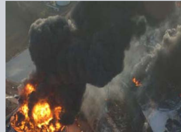
Tankfarm Buncefield, 40 km nordwestlich von London, UK am 13. Dezember 2005
