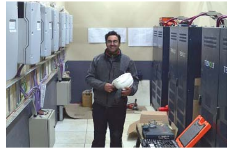
Hydro-Solar-Microgrid – Wasserturbinenanlage (l.), Tesvolt Energiespeicher (r.) und Photovoltaikanlage (u.).
