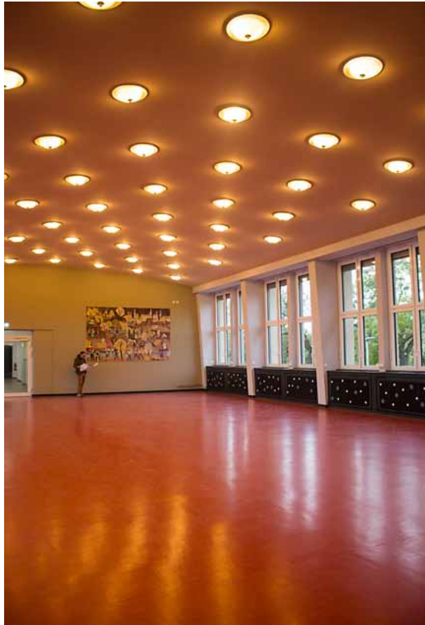
Der einstige Speisesaal im historischen DB-Verwaltungsgebäude wurde einschließlich Wandbild, Deckenbeleuchtung und Heizungsverkleidung mittels der BIM-Methode originalgetreu saniert. Fotos (3): Kathrain Graubaum
