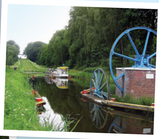
☛ BILD LINKS: DAS SCHIFF „OSTRÓDA“ MIT DEM TRANSPORTWAGEN AUF DER GENEIGTEN EBENE, OBERLÄNDISCHER KANAL, POLEN, URHEBER: HENRYK BORAWSKI; BILD RECHTS: GENEIGTE EBENE VON UNTEN GESEHEN, URHEBER: WSOMBECK
