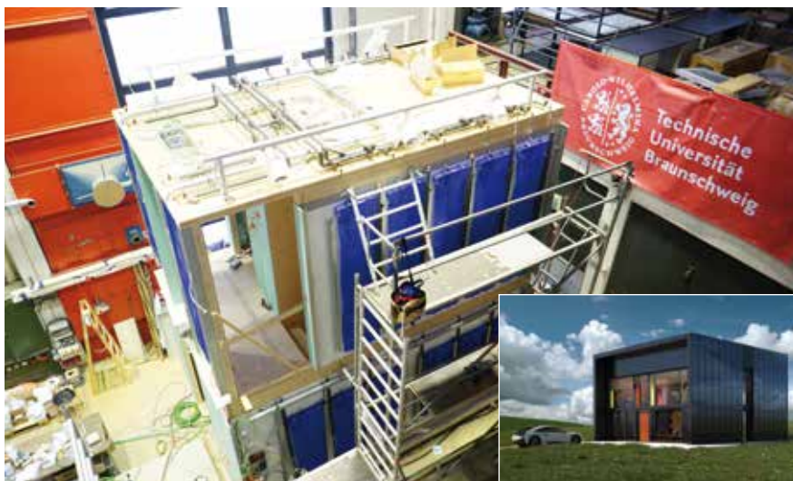
Der Technikkern, den Studierende aus Braunschweig bauen, versorgt das Haus mit Energie. Das Rendering zeigt, welche Form das Gebäude annehmen könnte.
