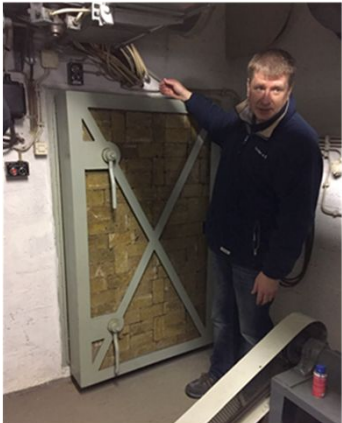
Vor der Strahlenschutztür (Bleieinlagerungen in den Steinen)
