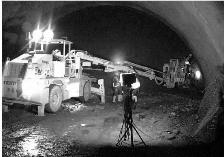
Der Vortrieb stellt hohe technische und technologische Anforderungen an das ingenieurtechnische Personal
